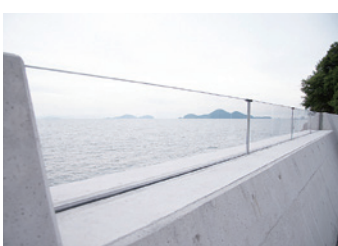
透明な防潮堤の施工例。広島県福山市田尻町にて。
